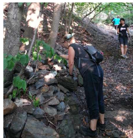
Oprava „mlochích zídok“
